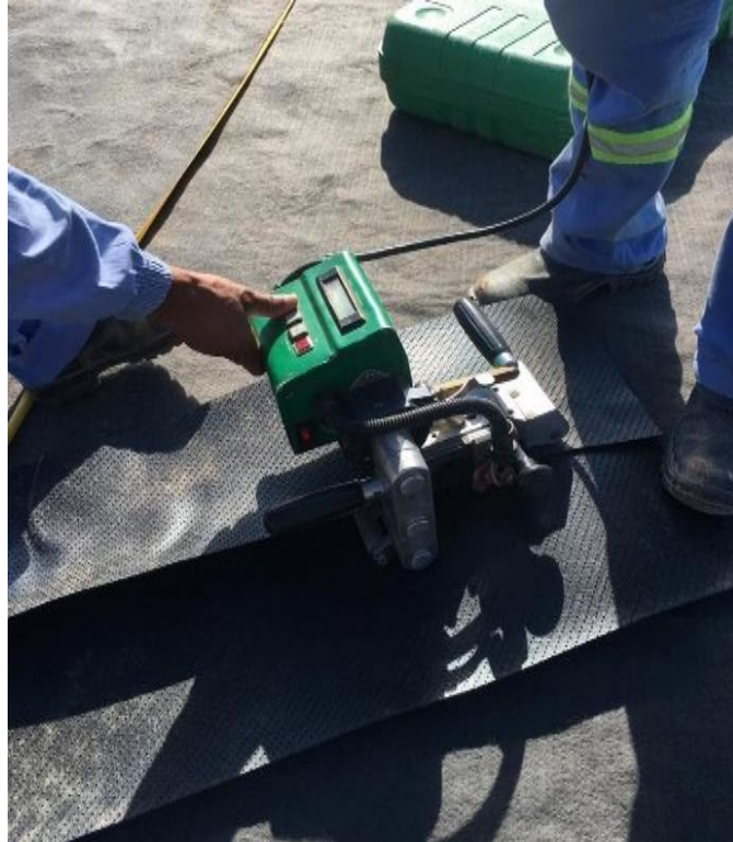
FIGURA 10 – Procedimento de solda, por termofusão da geomembrana de PEAD durante sua instalação em unidade operacional da UVS VIASOLO MONTES CLAROS.
