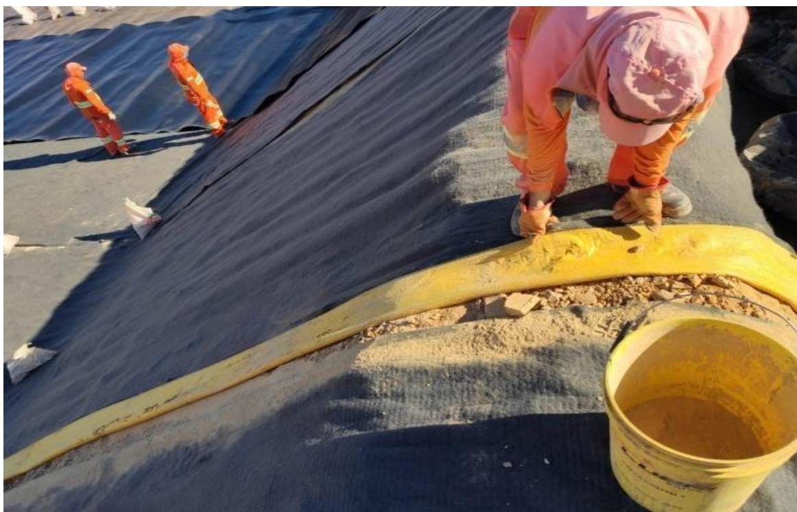
FIGURA 06 – Geocomposto beonítico (GCL) sendo instalado na unidade operacional da UVS VIASOLO MONTES CLAROS.
