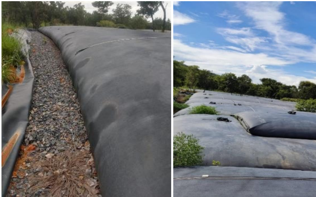
Figura 2. Bags de acondicionamento do lodo retirado da lagoa anaeróbia, assentados em leitos impermeáveis, dotados com drenagem para a água pluvial. Fonte: RADA
