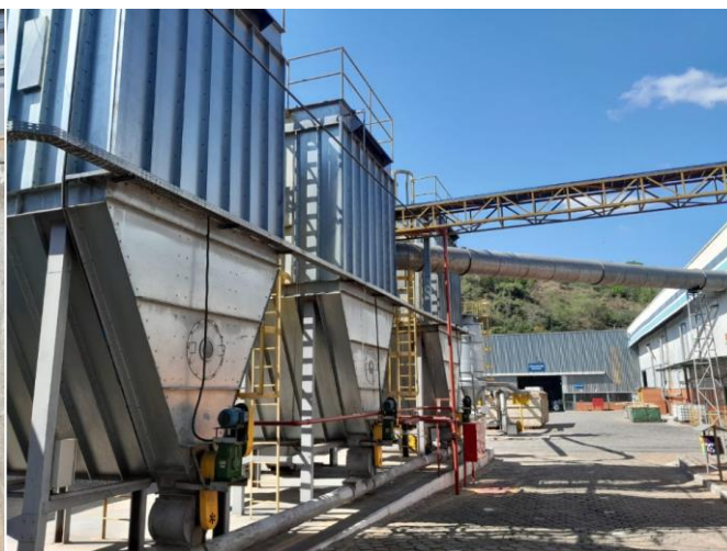
Figura 12: Sistema de exaustão para a coleta de material particulado nos setores de corte/usinagem da madeira.
