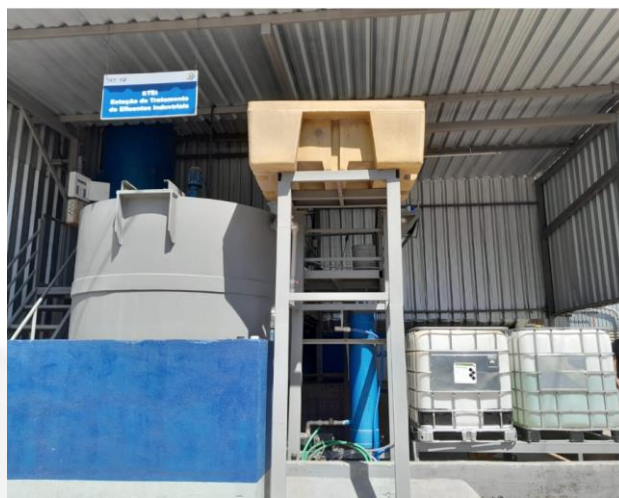
Figura 06: Estação de Tratamento de Efluentes Industriais (ETEI)
