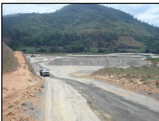
Foto 03. Área de transbordo e Triagem da Comercial. Caminhão com água usado para abafamento de poeiras.
