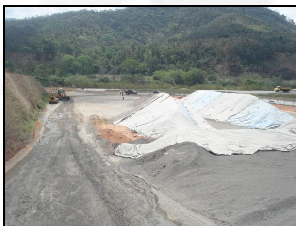
Foto 04. Área de Transbordo e Triagem da Comercial Cachoeira do Vale. Sucata fragmentada.
