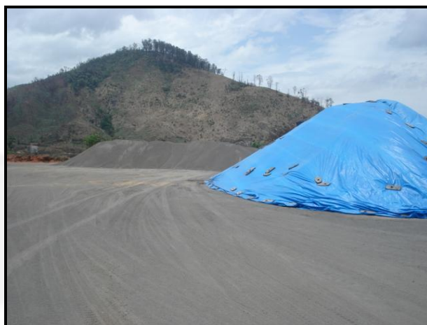
Foto 02. Área de transbordo e Triagem. Sistema de lonamento para proteger a sucata da chuva.
