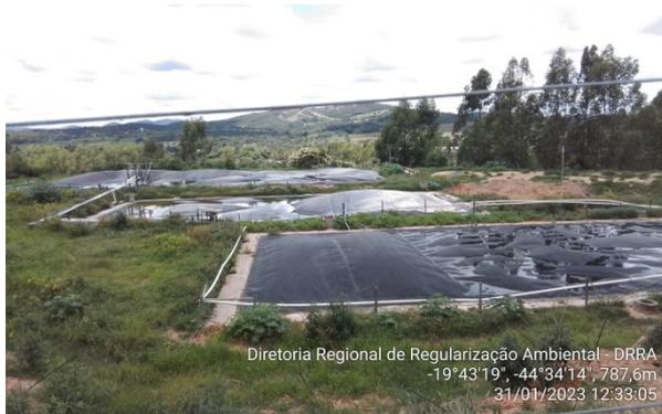
**Foto 05. Biodigestores do sistema de tratamento de efluentes suínos**
