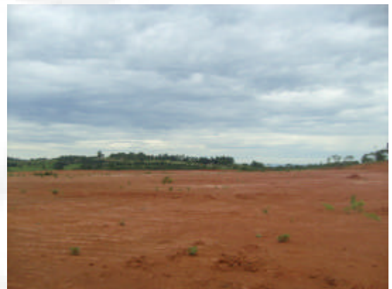
Foto 02. Área com terraplanagem
