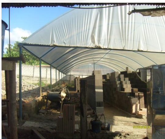
Foto 7: Estufa de secagem, sem sistema de drenagem pluvial implantado.
