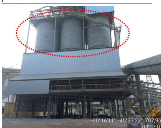
Foto 04. Silos de armazenamento da cal proveniente do Forno 09.
