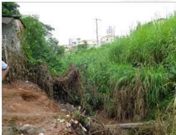
Foto 03- Residência situada à margem do córrego e Presença de lixo as margens do córrego
