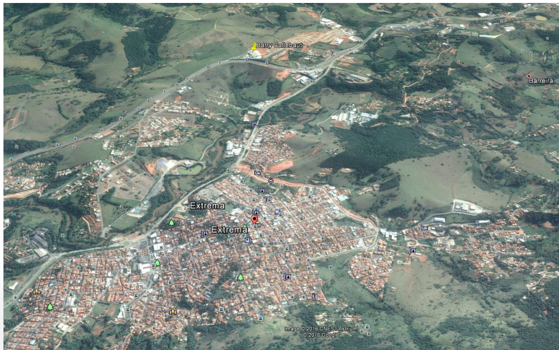
Vista geral de Extrema/MG com o empreendimento ao fundo
