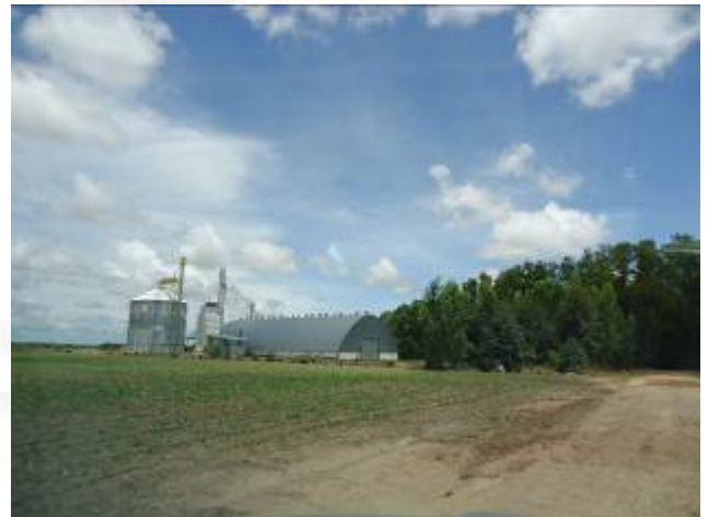
Foto 02. Estruturas de beneficiamento e armazenamento de grãos
