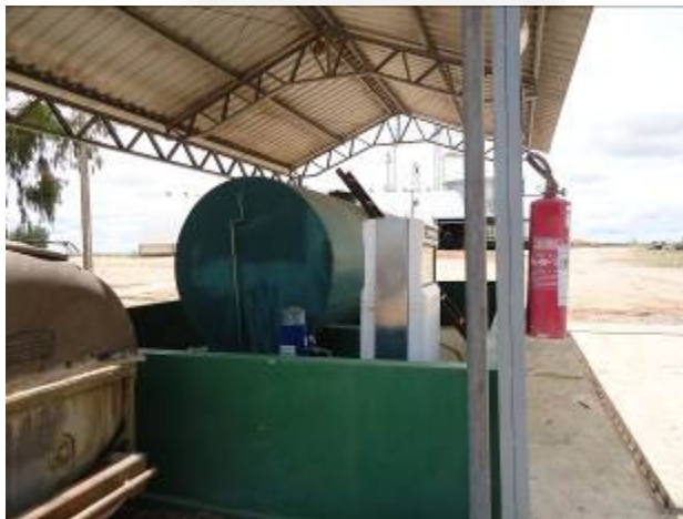
Foto 01. Ponto de abastecimento
