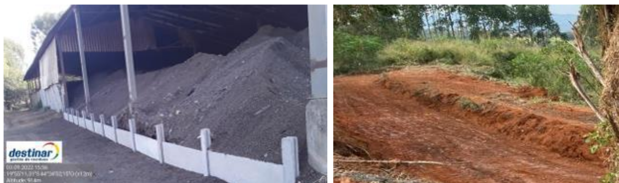
Figura 5. Sistema de contenção no entorno dos galpões e canaletas escavadas em solo
