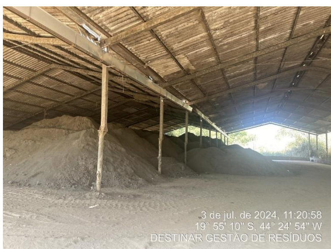
Foto 27: Vista do galpão do produto final (adubo)
