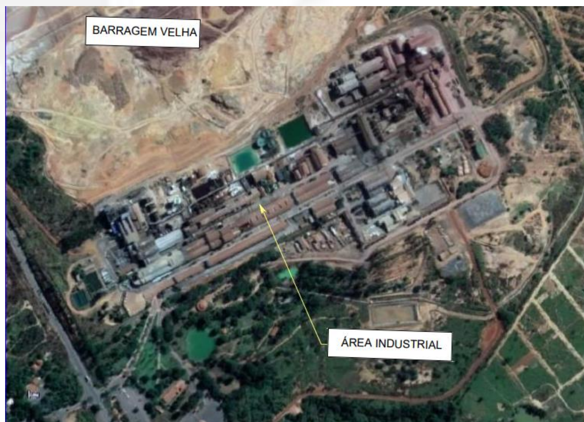
Figura 3, ampliação da área industrial e BV.
