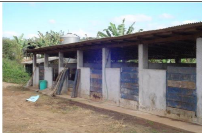
Figura 6: Casa de compostagem.
