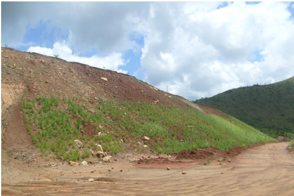
Figura 2: Talude reconformado e em estágio de revegetação.
