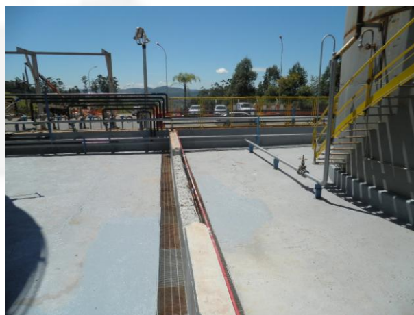
Foto 06. Bacias de contenção para os tanques
