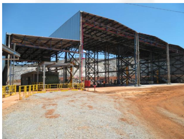
Foto 04. Infra-estrutura do posto de abastecimento
