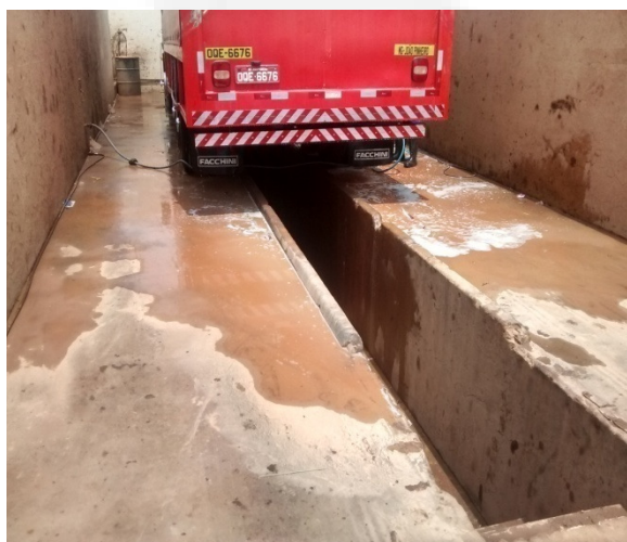
Foto 03: Lavador de veículos
