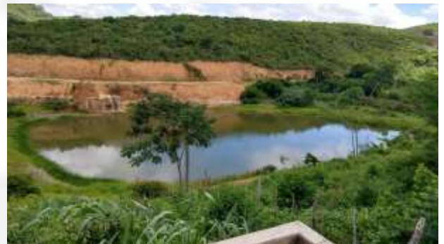
Foto 6: Área do barramento
