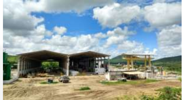
Foto 2: Vista Geral da Estrutura
