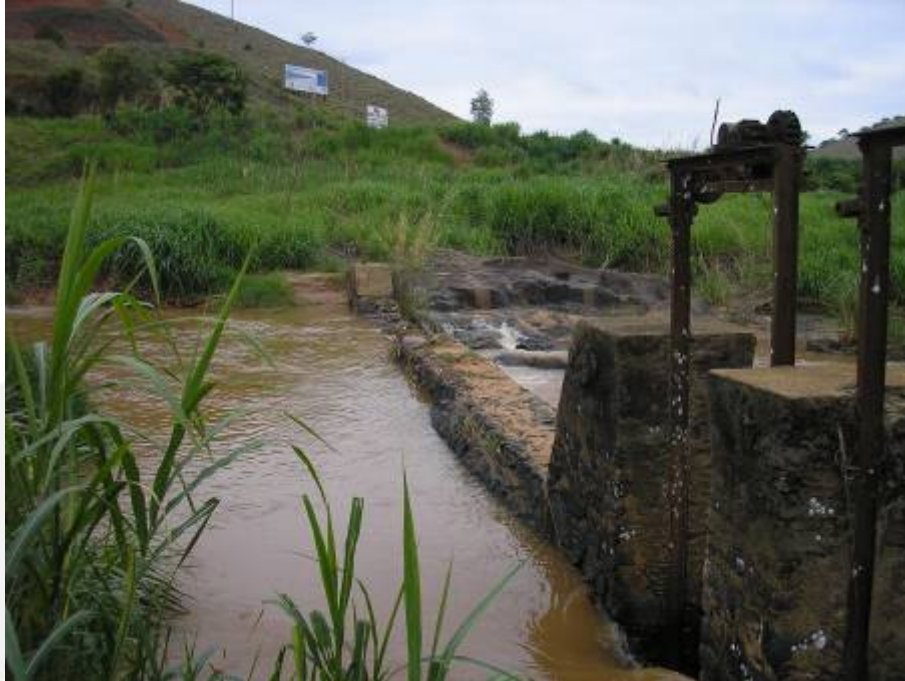
Foto 01: Vista do barramento já construído e que será reformado.
