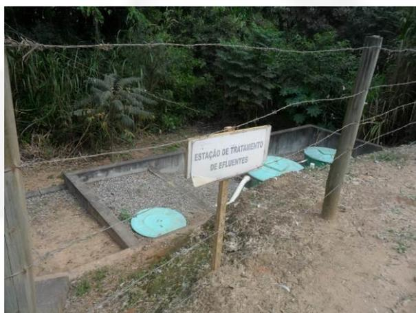
**Foto 04.** Estação de tratamento de efluentes sanitários
