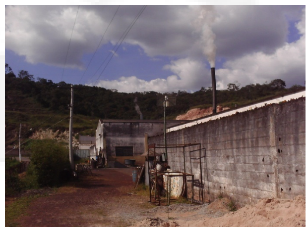
Foto 04. Imagem do ponto de emissão da chaminé das caldeiras.
