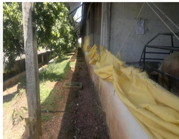
**Foto 04.** Galpão de suínos com caixas de recebimento de efluente, a vegetação dos taludes e sistema de drenagem pluvial
