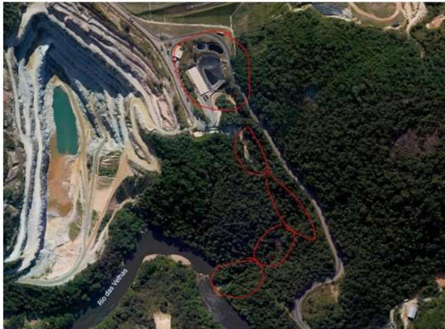
Figura 3. Vista área de todo o canal desde o local de deposição do chorume até chegada no rio das Velhas, Aterro de Macaúbas - Sabará/MG.
