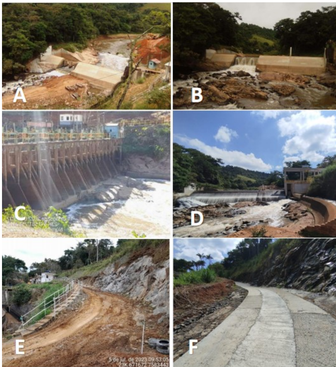
Figura 17 - A) e B) Arranjo da CGH Paciência na fase 1 da obra de recapacitação dos vertedouros (dezembro/2022). C) Arranjo do barramento da CGH Paciência antes das obras de readequação. D) Arranjo do barramento da CGH Paciência após das obras de readequação em 2024. E) Acesso ao barramento e tomada d'água durante a fase de obras em 2022, e F) Mesmo local de acesso após a conclusão das obras em 2024. Fonte: Cemig, 2022; Clam, 2022. FEAM, 2024.
