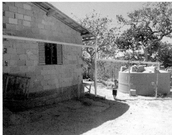
Foto 17. Caixa de captação de água pluvial
