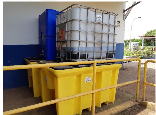
Foto 08. Bombona contendo óleo usado sobre bacia de contenção
