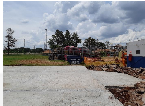
Foto 06. Novo pátio impermeável para colocação de caçambas
