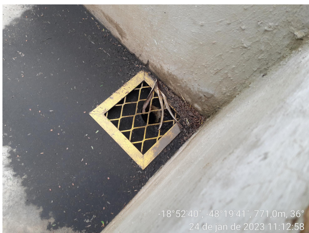
Foto 03: Saída da bacia de contenção do tanque de combustível para a CSAO
