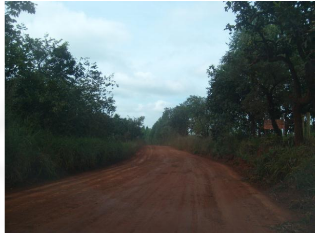
Foto 2: Início trecho MG-827
