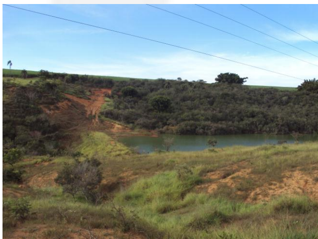
Foto 7: Intervenção da 2ª Variante – Margem Esquerda do Lago
