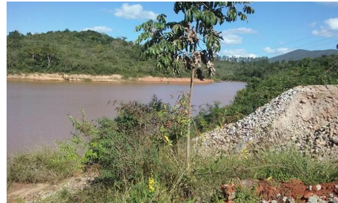
F4 – Reservatório do Dique 1 - a ser descomissionado
