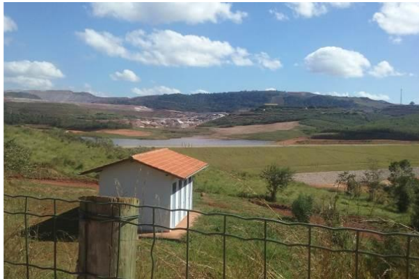
que 2, a jusante do grupamento 1 - Implantado em enchimento
