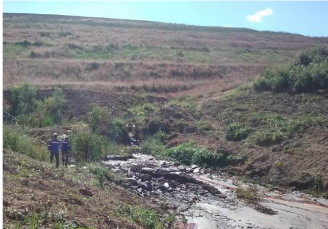
F1 – Saída de dreno já implantado da PDE
