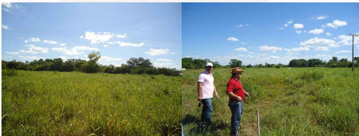
Foto 07. Local onde será instalado parte do dique.
