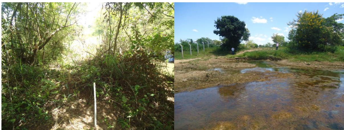
Foto 06. Local onde será instalado parte do dique.
