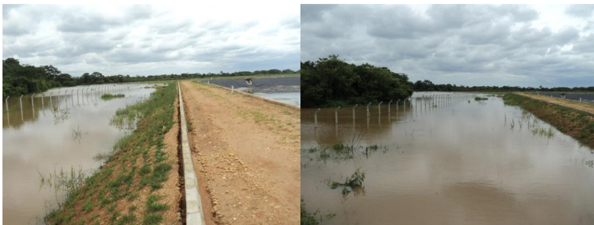
Foto 12. Alagamento da área da Estação de Tratamento de Efluentes Sanitários.
