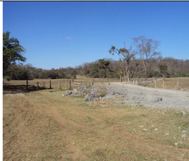
Foto 05: Estrada de acesso
