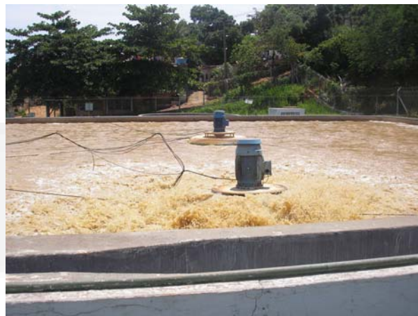
Foto 02. Estação de Tratamento de Esgotos
