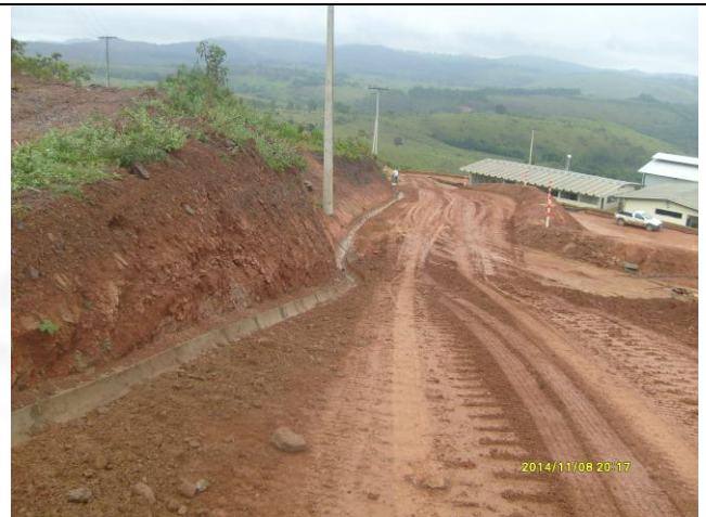
Foto 08: Sistema de drenagem nas vias internas.
