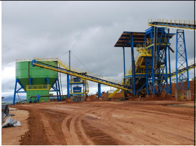
Foto 05: Usina de beneficiamento mineral.
