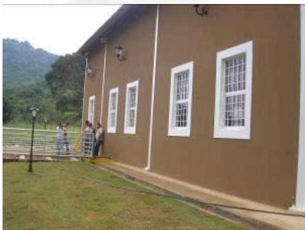
Foto 3: Casa de força.
