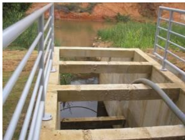
Foto 4: Canal de fuga.
