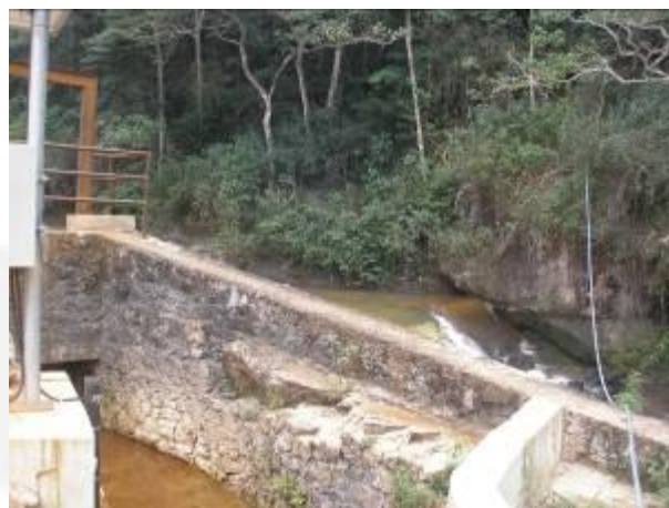
Foto 2: Canal de adução.
