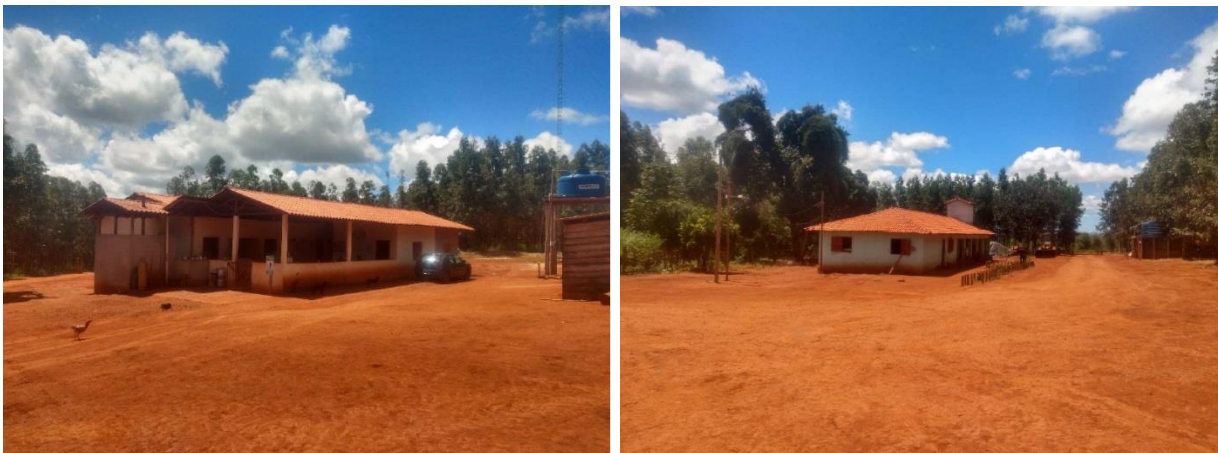
Fotos 3 e 4 – Área de apoio aos funcionários (alojamentos e refeitórios).
