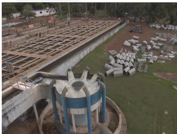
Foto 07. Alteração do ponto de dosagem dos produtos químicos e medição da vazão de água no início do tratamento – Instalado.
