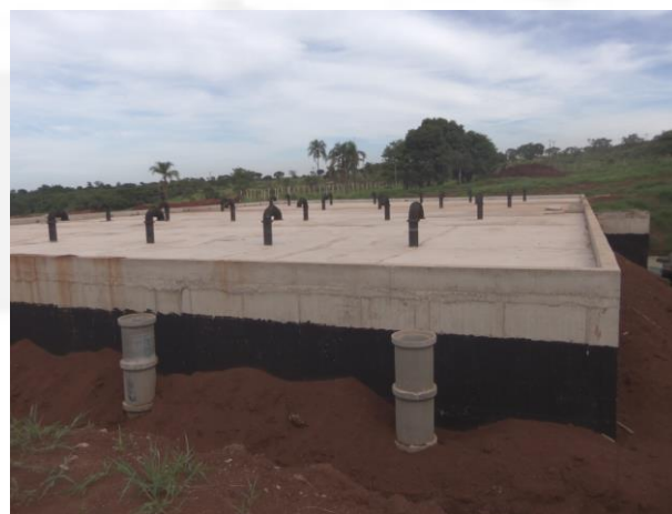
Foto 04. Inserção do Reservatório de Acumulação – praticamente finalizada.
