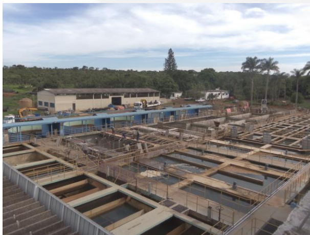
Foto 01. Obras de Reformulação dos Decantadores e Floculadores – em etapa final de conclusão.
