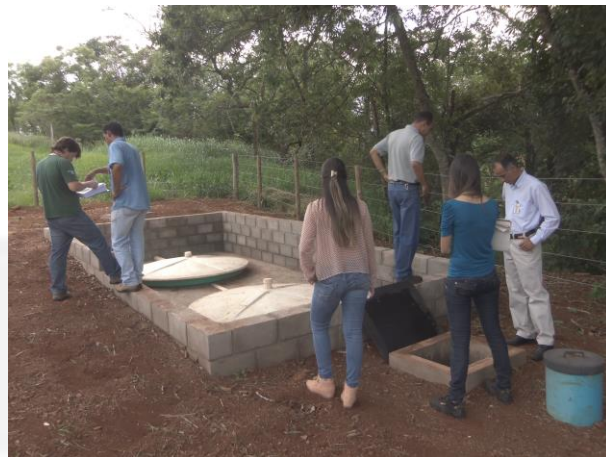
Foto 10. Fossa Séptica, com filtro anaeróbio e vala de infiltração – Instalada.
