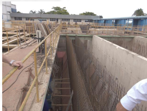
Foto 02. Obras de Reformulação dos Floculadores – em etapa final de conclusão.
