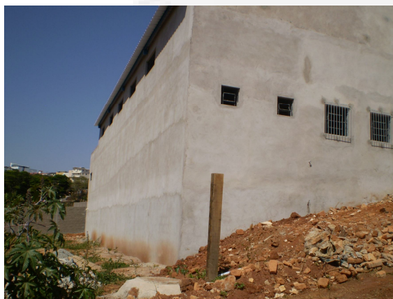
Foto 01. Empreendimento já sendo instalado
