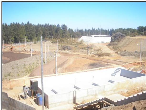
**Foto 02.** Bacia de Contenção, com Piso Impermeabilizado da área dos Tanques de Emulsão.
