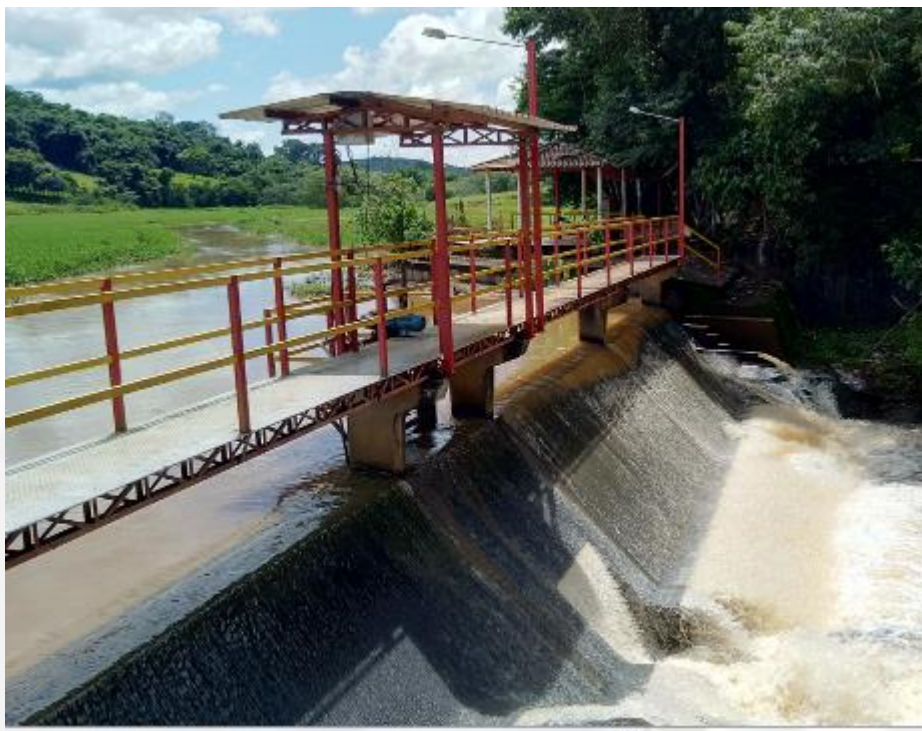
Foto 01. Vista barragem com comporta de fundo e vertedouro.
