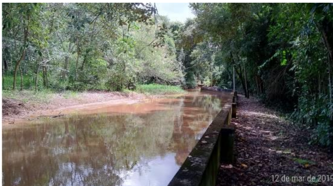
Foto 03. Vista parte do canal adutor.
