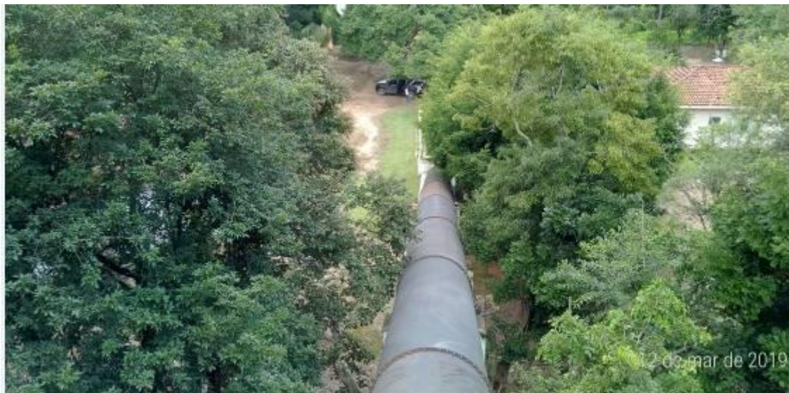
Foto 05. Vista do conduito forçado.
