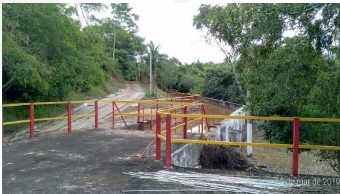
Foto 06. Vista do final do canal adutor.
