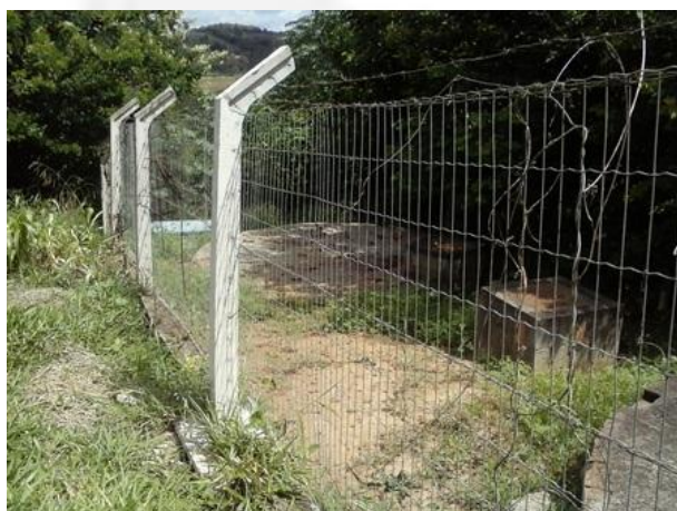
Foto 09. Estação de tratamento de esgoto
