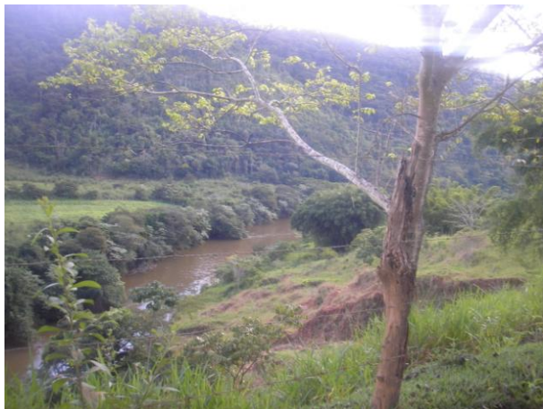
Foto 01. Região do Barramento da PCH Canastra
