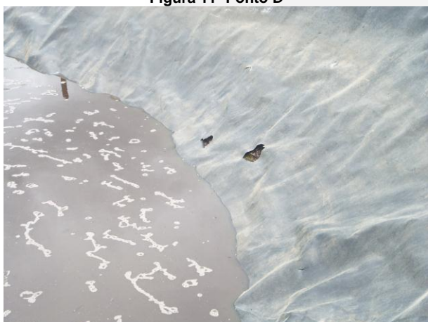
Figura 13- Furos nas Lagoas de tratamento de efluentes
