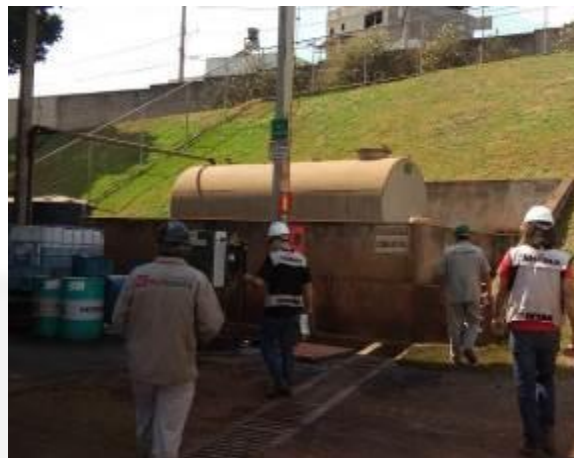
Foto 06. Área de abastecimento de veículos.
