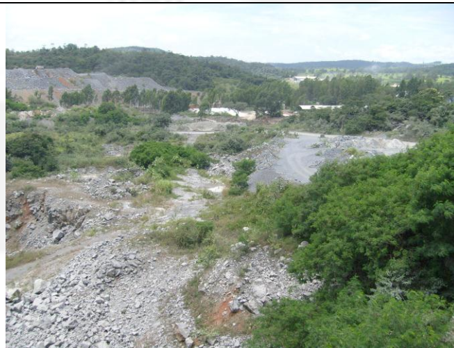
Foto 08: Vista do local de implantação da pilha de estéril
