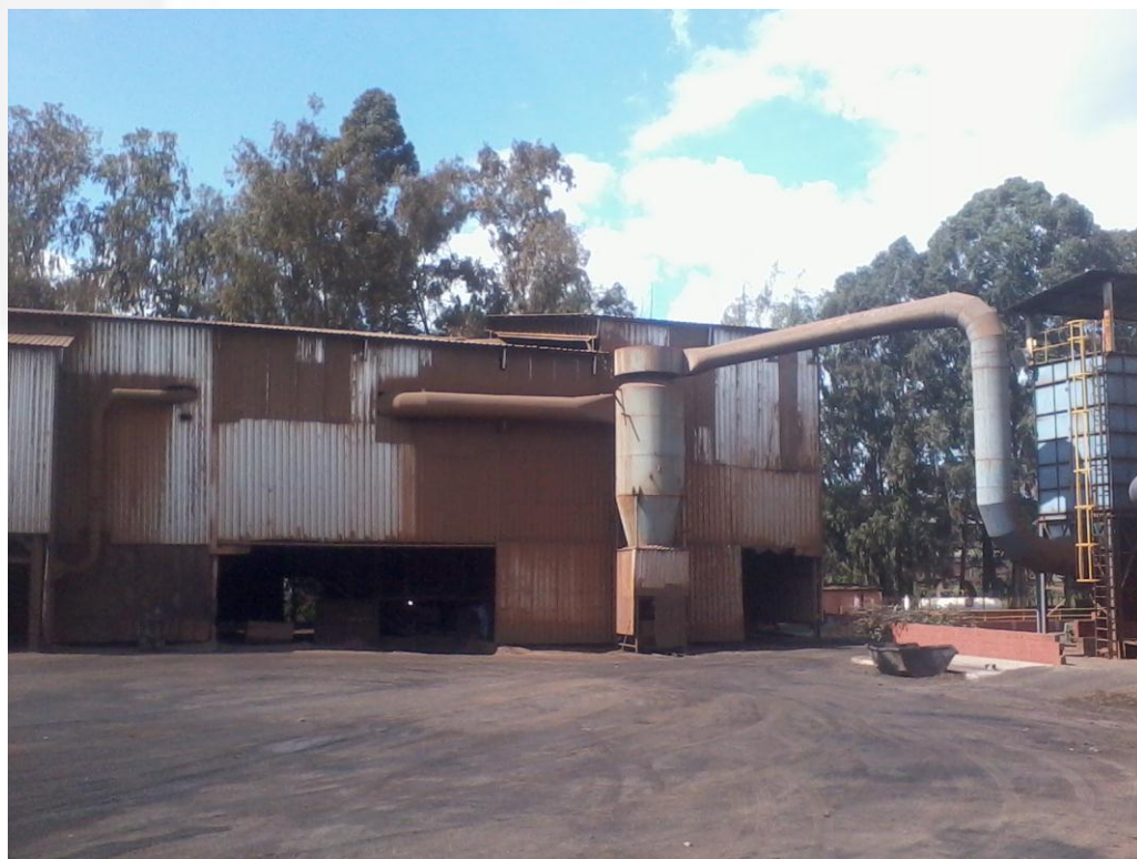
Fotos demonstrando as emissões fugitivas (Material Particulado) e o sistema de captação do material particulado da Sinterização (Filtro de mangas).
