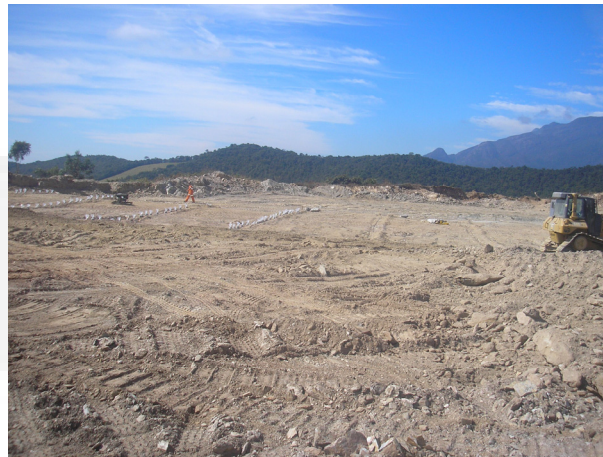
Foto 02. Área da Cava
