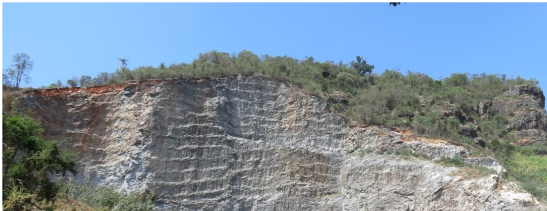
Figura - Frente de lavra da pedreira, mostrando a ausência de perfil de solo, ou solo pouco espesso na porção esquerda da foto.
