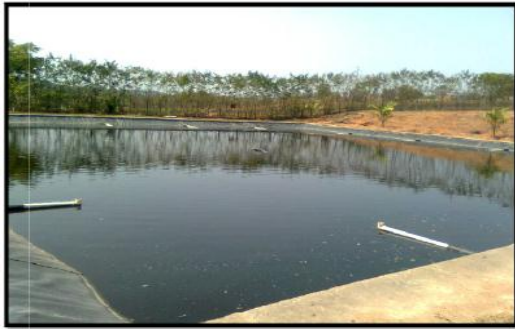
- Lagoa de decantação.
