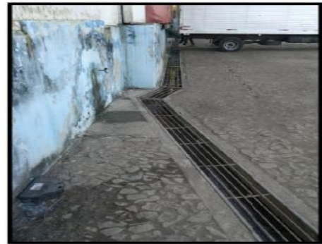
- Canaleta de drenagem.
