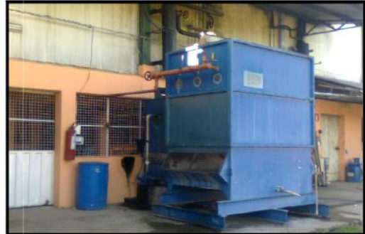
- Reservatório de água.
