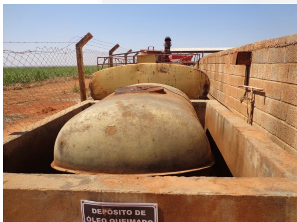
Fig. 13. Depósito de óleo usado e ao fundo reservatório de água a ser reutilizada no lavador
