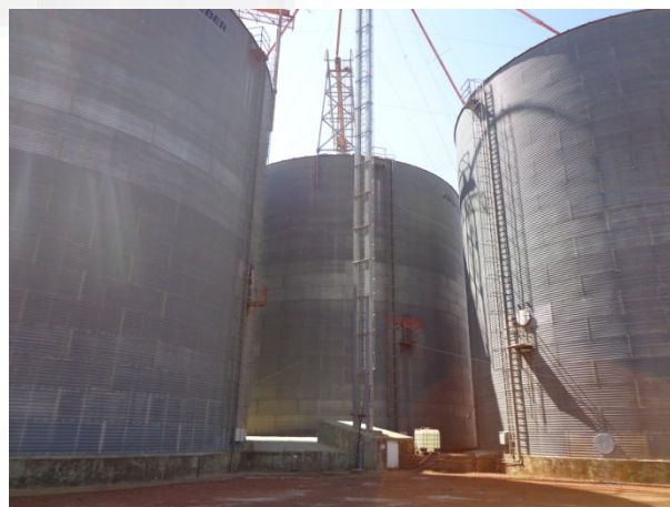
Fig. 14. Silos de armazenamento
