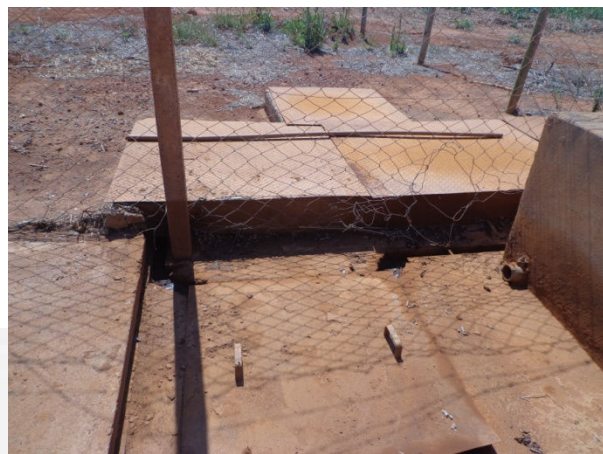
Fig. 12. Lavador de veículos - Caixa SAO
