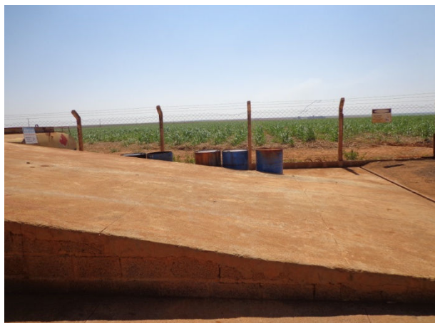
Fig. 11. Lavador de veículos
