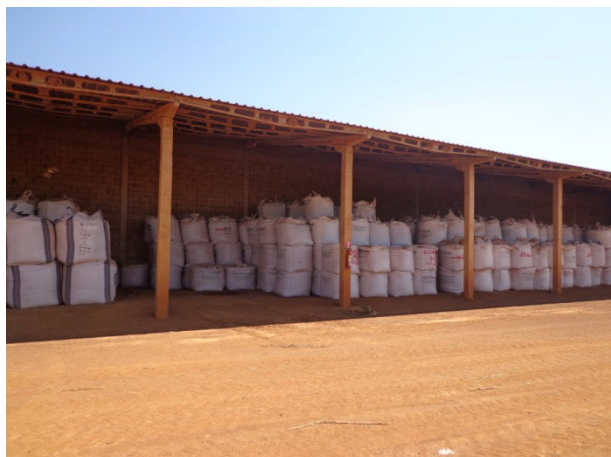
Fig. 05. Galpão de armazenamento de fertilizantes
