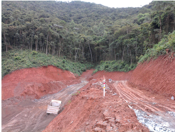
Foto 01. Vista geral demonstrando a fase final das obras da pilha.
